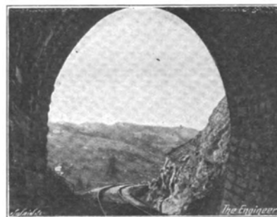
Fig. 30—LOWER PORTAL OF D'UM D'UM TUNNEL
