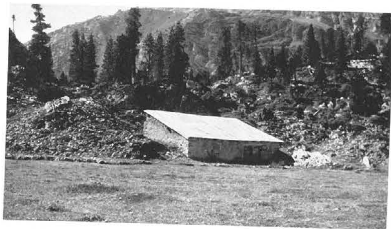
Abb. 272, Seite 119 Trockenmauerwerk, Fugen mit Mörtel ausgeworfen (sinnlose Konstruktion)
