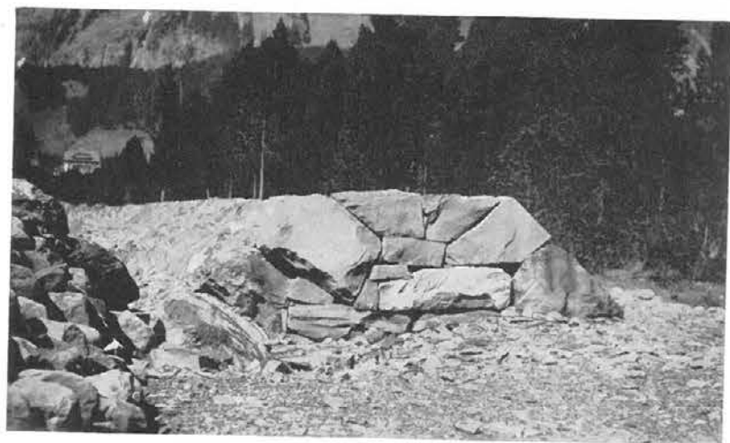
Abb. 253, Seite 116 Solider Mauerabschluß
