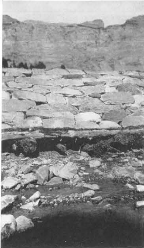
Abb. 204, Seite 110 Lamellenweises Unterfangen am Platze
