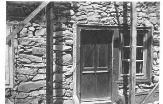
Abb. 143 und 144, Seite 93 Der Naturstein ist vom Verputz befreit
