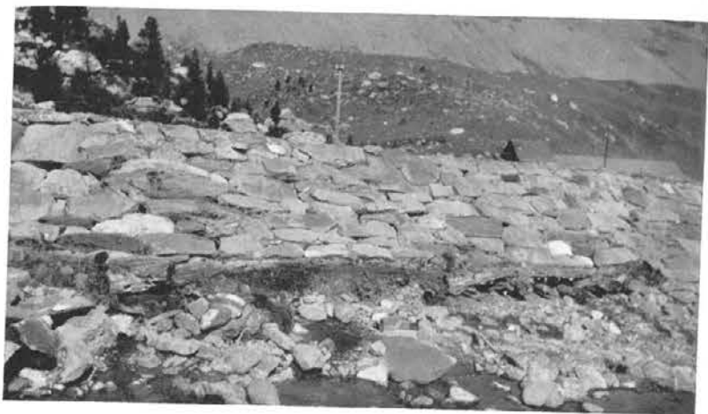
Abb. 281, Seite 120 Schlechte Fundation (Oberbau gefährdet)
