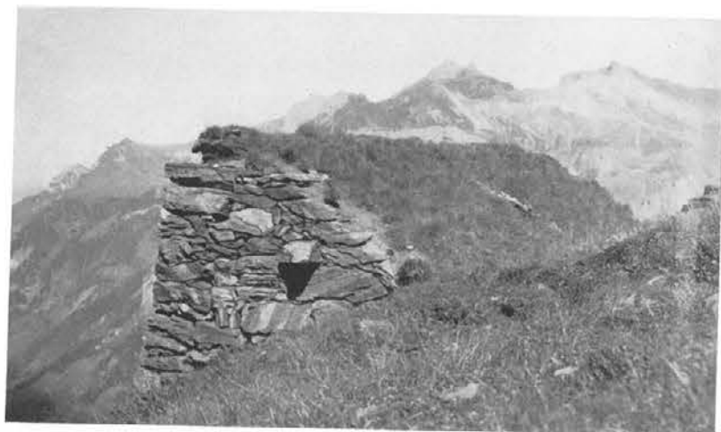
Abb. 252, Seite 116 Lawinenschutzmauer
