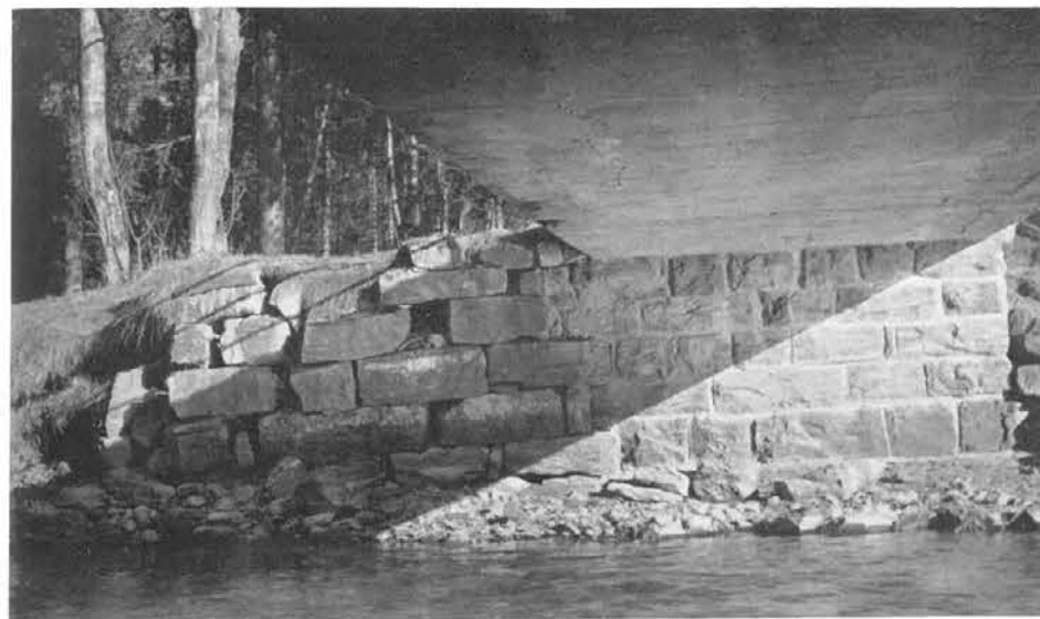
Abb. 197 und 198, Seite 109 Höchste Zeit zur Neuerstellung dieses Flügels
