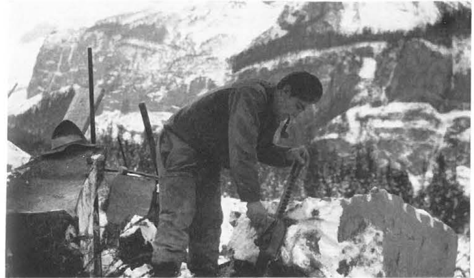
Abb. 182, Seite 105 Richtige Handhabung der Fußwinde
