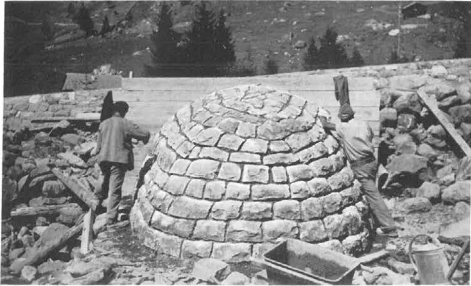
Abb. 140, Seite 92 - Ausfugearbeiten
