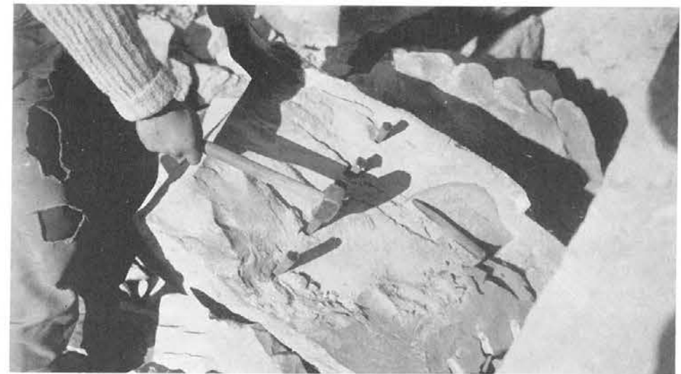
Abb. 44, Seite 47 Aufbrechen eines Steines mit Ponciottos
