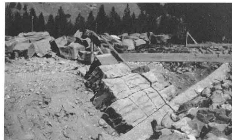
Abb. 27, Seite 39 Trockenmauerwerk. Dank kunstgerechtem Aufrüsten konnte ein mustergültiges, lagerhaftes Mauerwerk entstehen. Rüstarbeit siehe Tafeln 6 bis 11.
