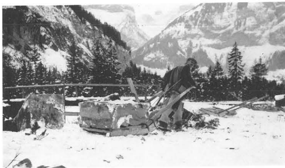
Abb. 52, Seite 50 Die Baustelle ist erreicht
