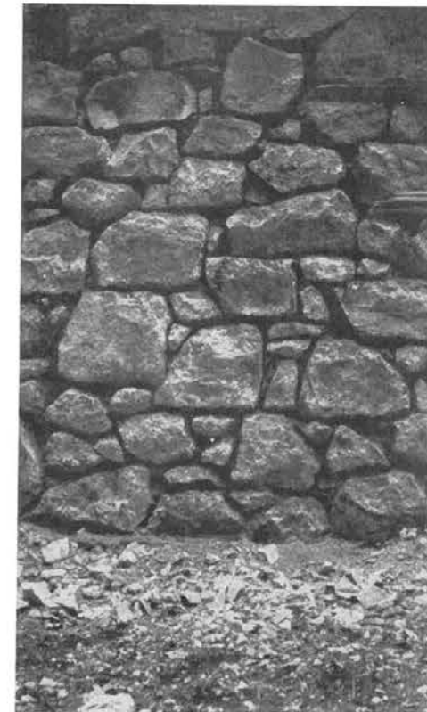
Abb. 139, Seite 92 Teilstück, fertig zum Ausfugen
