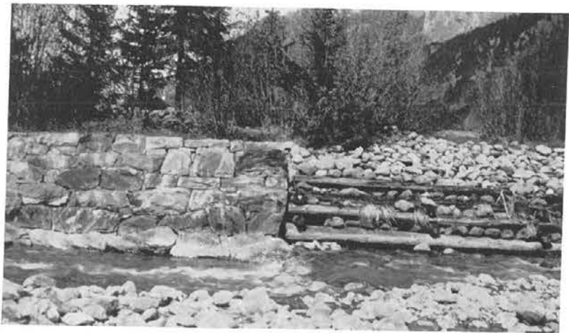
Abb. 280, Seite 120 Wildbachverbauung einst und jetzt
