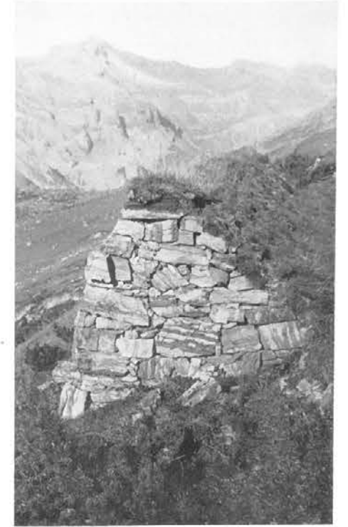
Abb. 250, Seite 116 Steine materialgerecht verwendet, handwerklicher Aufwand gering
