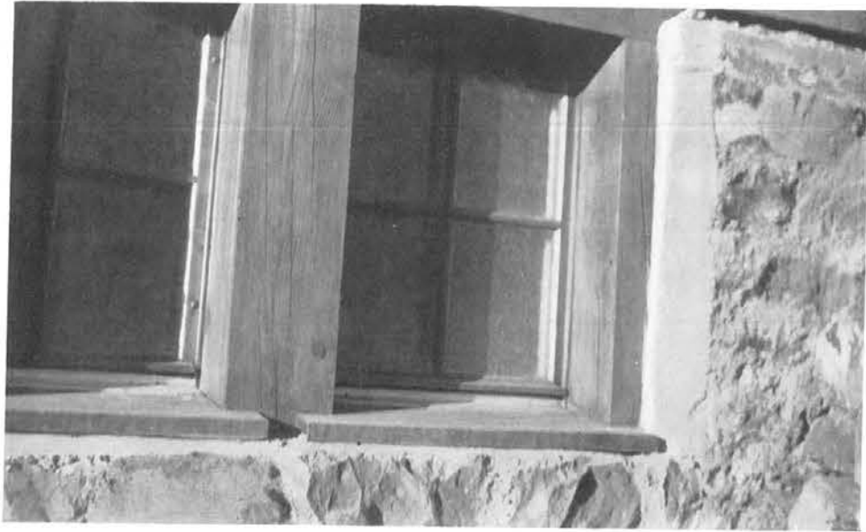
Abb. 230, Seite 114 Die Fensterbank sollte unbedingt vorspringen
