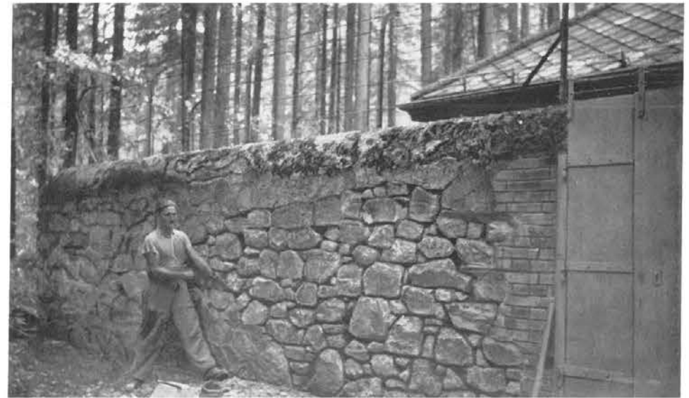
Abb. 138, Seite 92 Maurer beim Ausspitzen von Fugen
