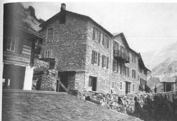
Abb. 25, Seite 39 Schroppenmauerwerk (die ganze Arbeit wurde vom Maurer ausgeführt)
