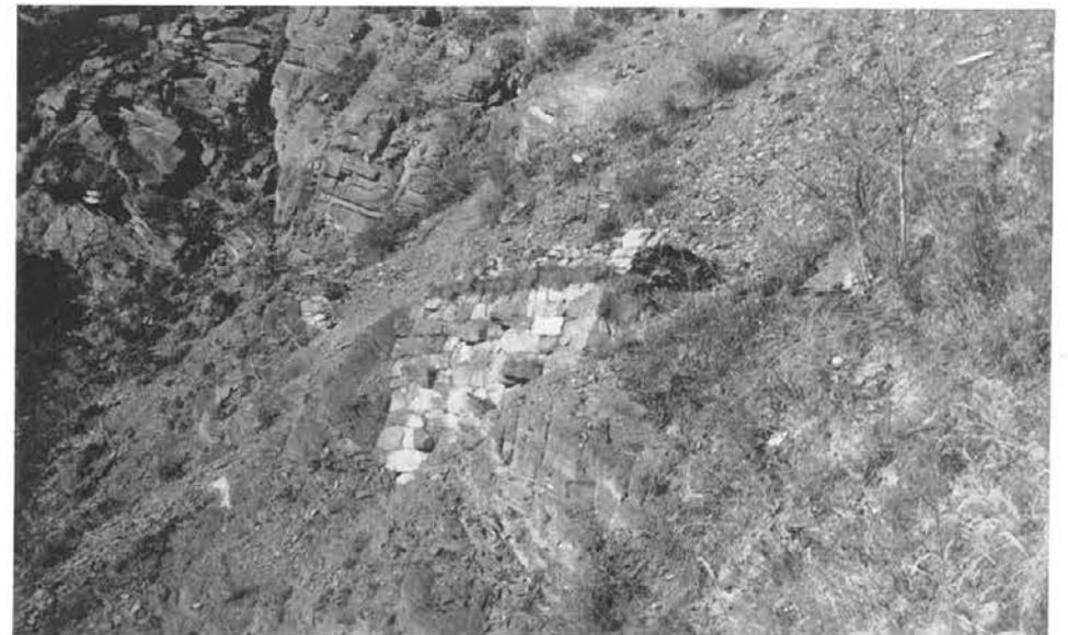
Abb. 298, Seite 124 Solides Trockenmauerwerk
