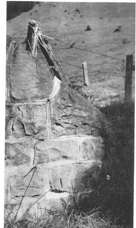
Abb. 244, Seite 116 Geringe Ausfugearbeit
