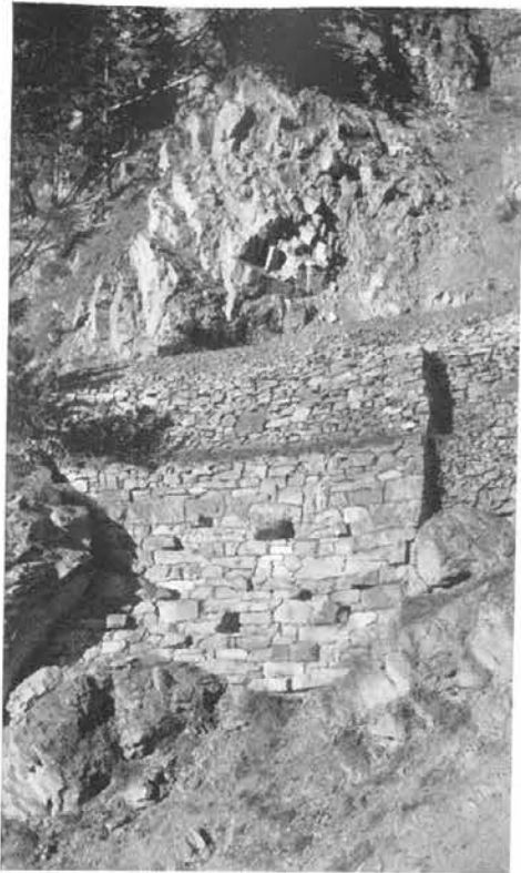
Abb. 304, Seite 124 Zwischen Fels mit guter Fundation eingebaute Mauer (gute seitliche Sicherung)
