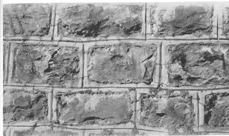
Abb. 156, Seite 95 Kerbfuge (nicht zu empfehlen)
