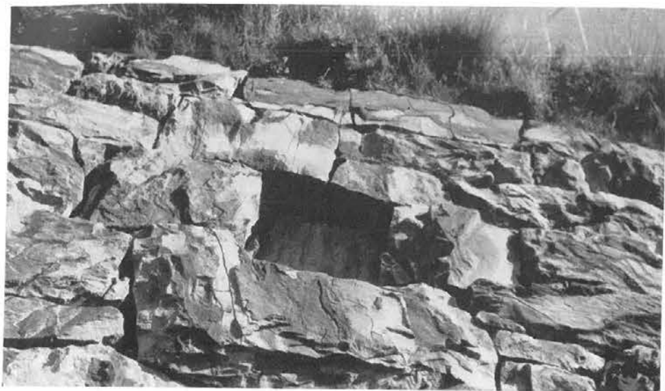
Abb. 189 und 190, Seite 108 Die entstandenen Löcher sollten sofort ausgeflickt werden
