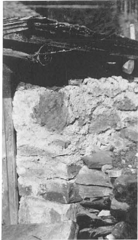
Abb. 169, 170 und 171 Seite 96 Auch bei unwesentlichen Bauarbeiten wollen wir den Naturstein nicht mit Mörtel beschmutzen
