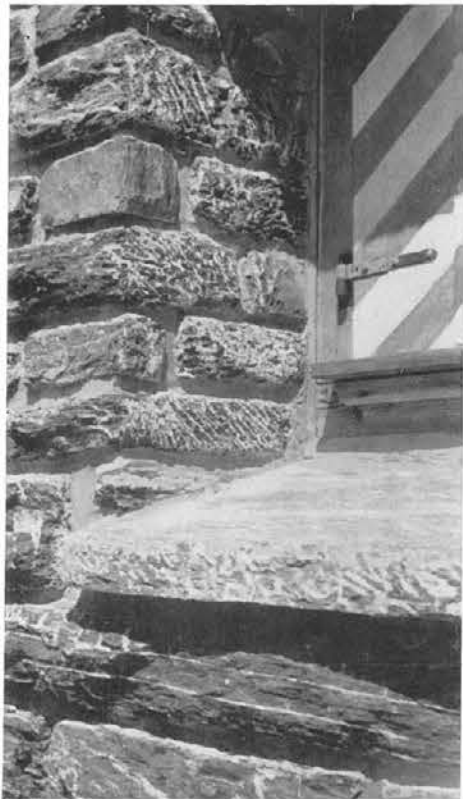
Abb. 226, Seite 113 Auf Spaltgang gutgehender Stein. Auf Brechgang schlecht. Aus wirtschaftlichen Gründen wurde ein Steinhauer beigezogen zur Bearbeitung der Stoßflächen
