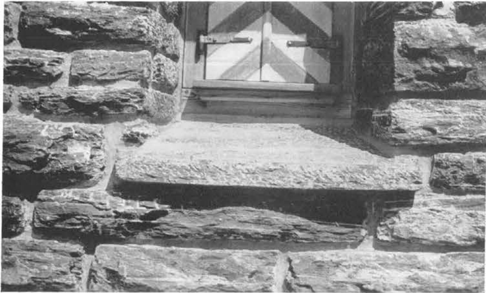
Abb. 225, Seite 113 Die Fensterbank muß genügend Gefälle aufweisen
