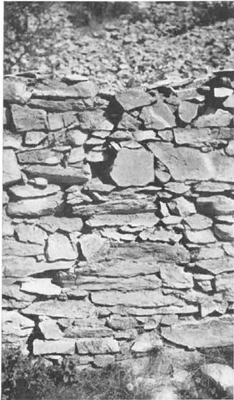
Abb. 185, Seite 108 Mauer aus ungerüsteten, in der nächsten Umgebung zusammengetragenen Steinen
