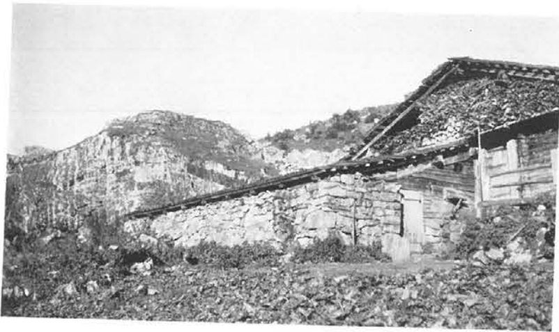
Abb. 271, Seite 119 Trockenmauerwerke in doppelhäufiger Aufführung bedingen große Handwerkerkunst
