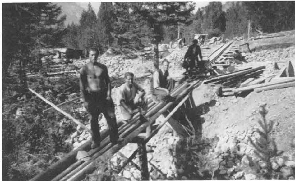
Abb. 57, Seite 50 Installation einer horizontalen Rollbahnanlage
