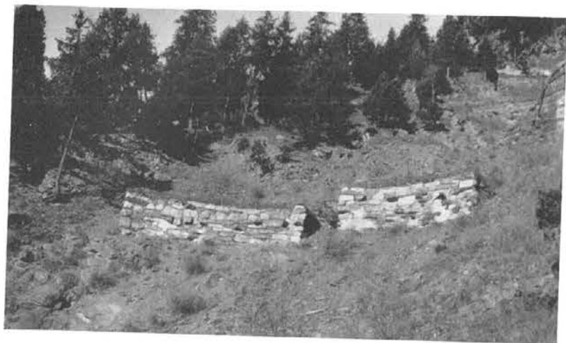
Abb. 299, Seite 124 Kurvenmäßig gut ans Terrain eingebaute Trockenmauern
