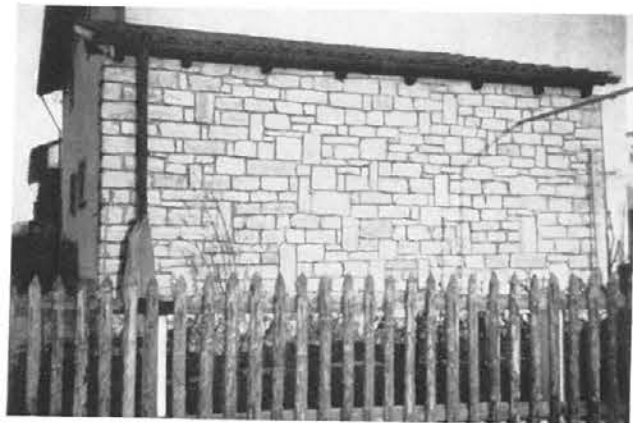
Abb. 322, Seite 129 Schottisches Mauerwerk
