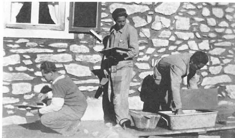
Abb. 154, und 155 Seite 94 Vorbildlich ausgefugtes Schroppenmauerwerk
