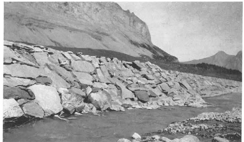
Abb. 203, Seite 110 Vom Wasser gefährdetes Fundament
