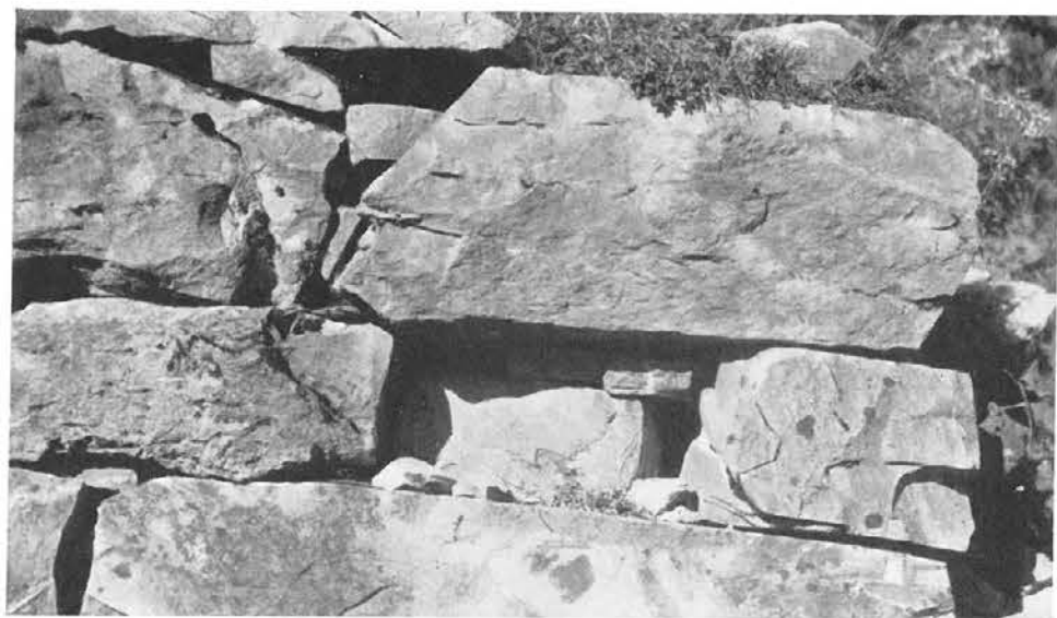
Abb. 189 und 190, Seite 108 Die entstandenen Löcher sollten sofort ausgeflickt werden
