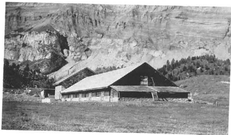
Abb. 273, Seite 119 Gut proportioniertes Sennhaus. Vorn Unterkunft für das Vieh, hinten Unterkunft der Sennen mit Käseerei
