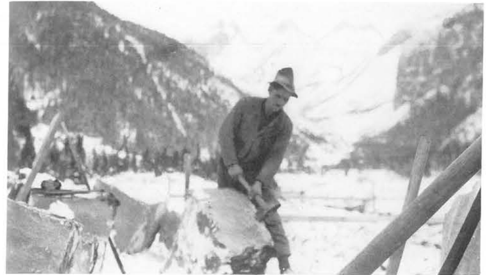
Abb. 74, Seite 58 Urchiger Natursteinmaurer mit typischer Richthammerführung
