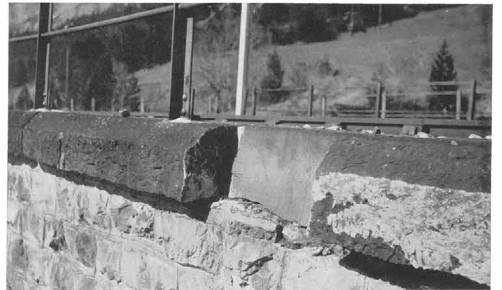
Abb. 209, Seite 112 Typisch falsche Lagerung des Steines. Sache des Steinhauers
