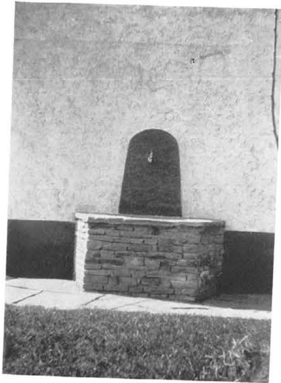
Abb. 325, Seite 120 Typisches Plattenmauerwerk
