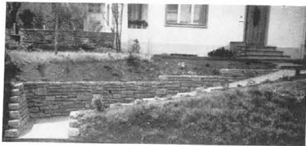
Abb. 321, Seite 129 Abschluß links etwas gefährdet
