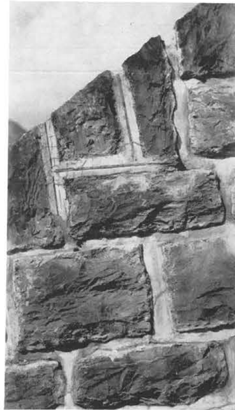
Abb. 243, Seite 116 Mauerwerk, teilweise mit Kerbfuge, teilweise frisch ausgefugt
