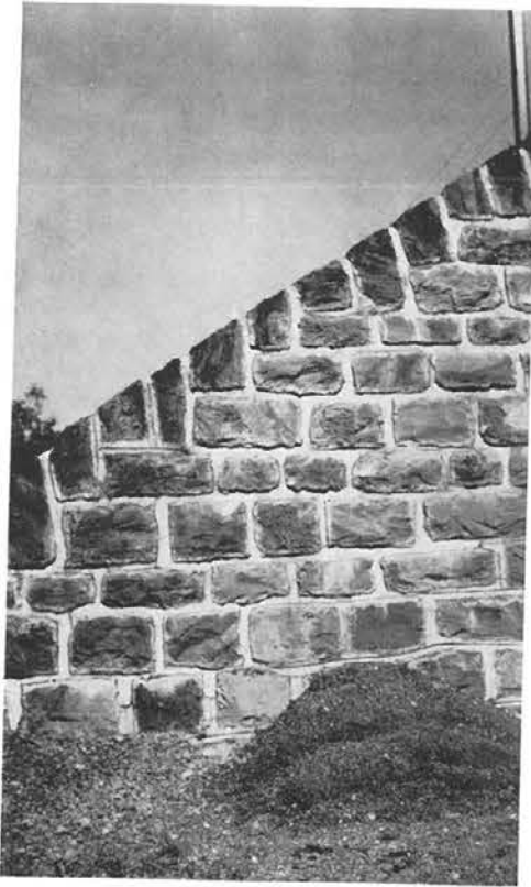
Abb. 241, Seite 116 Neu ausgefugte Flügelmauer (teilweise Kerbfuge sichtbar, neues Stück nach einfacherem Verfahren)
