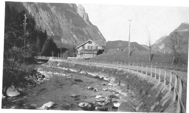
Abb. 285, Seite 120 Man achte speziell auf die flüssige Kurve. Gleichmäßiges Einteilen der Profile (gleiche Distanzen)
