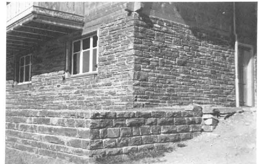
Abb. 21, Seite 39 Plattenmauerwerk (siehe Verhältnis Höhe zur Länge der einzelnen Steine an der Fassade)
