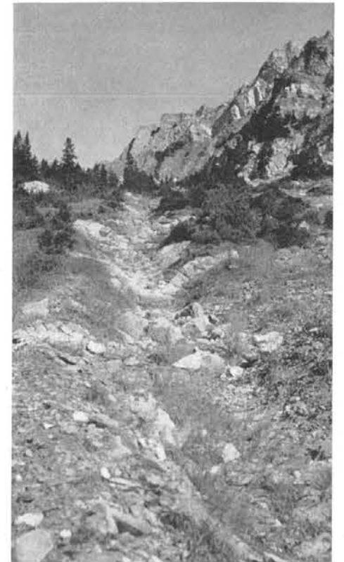
Abb. 297, Seite 124 Verbauung gegen das Tieferfressen des Wassers (gegen das Bilden von Gräben)
