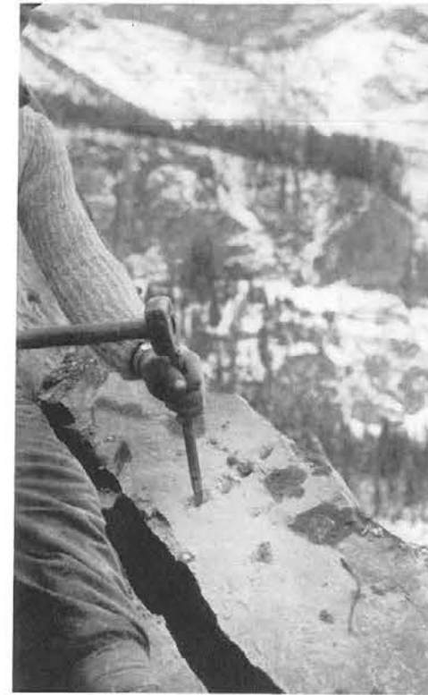
Abb. 43, Seite 47 Ausspitzen von Ponciottolöchern (Handarbeit)
