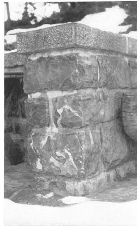
Abb. 249, Seite 116 Abdeckplatten durch Steinhauer, Mauersteine durch Maurer bearbeitet
