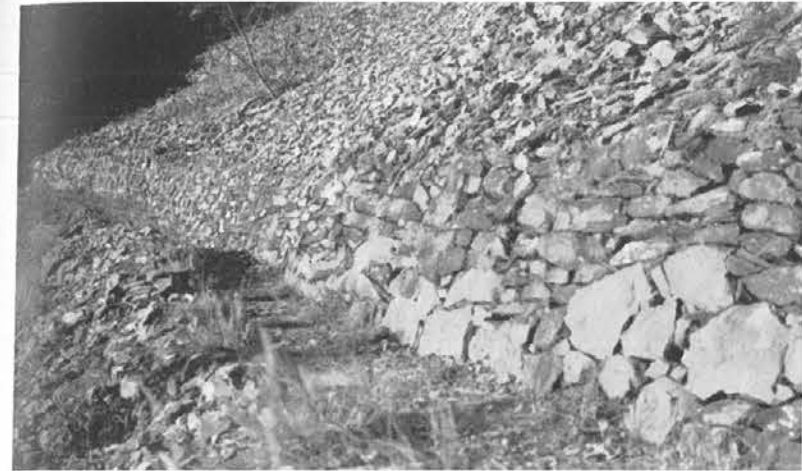
Abb. 306, Seite 124 Die Stützmauer hält das ganze Material zurück
