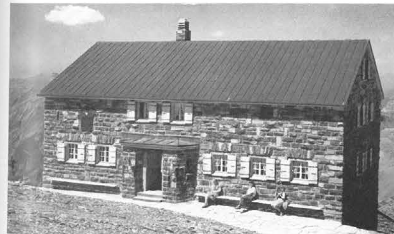
Abb. 22, Seite 39 Schottisches Mauerwerk
