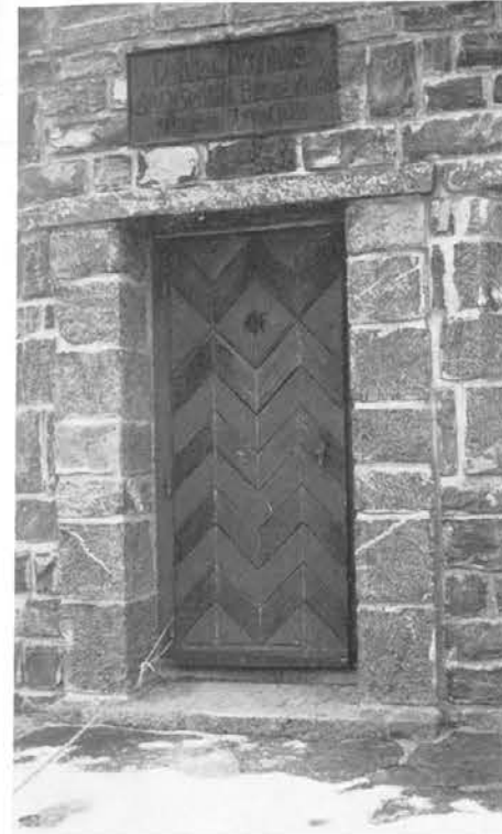
Abb. 217 und 218, Seite 113 Bei solchen Arbeiten sollten die Steine vom Steinhauer und nicht vom Maurer zugehauen werden (Erstellungskosten sonst zu teuer)
