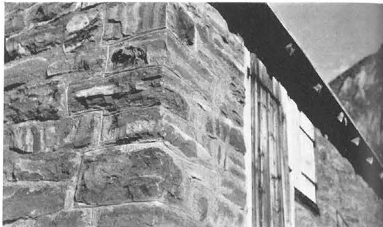
Abb. 160, Seite 95 Revolverstein in einer Fassade (zweiteiliges unteres Lager)
