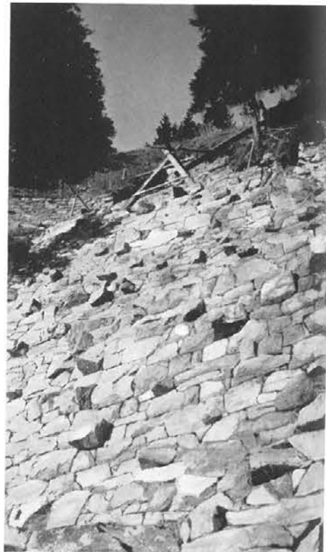
Abb. 305, Seite 124 Die vorspringenden Steinköpfe verraten das regelmäßige Einbinden der Mauer
