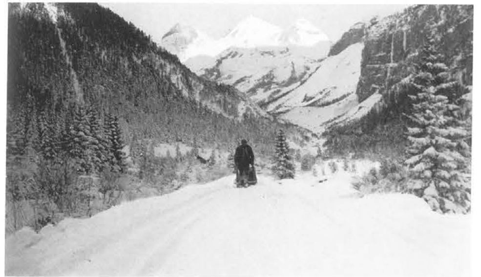
Abb. 51, Seite 50 Steintransport zur Baustelle
