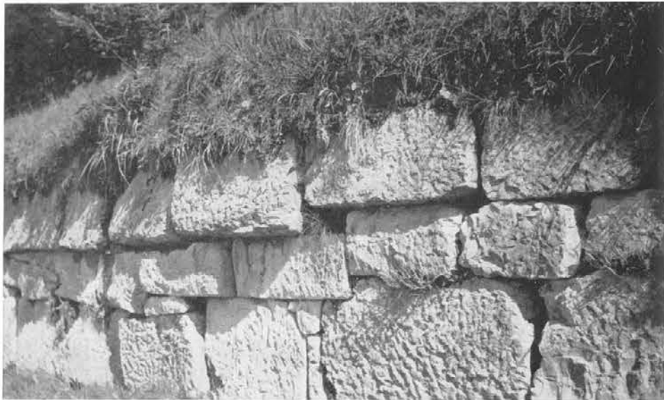
Abb. 207, Seite 111 Lösung der Reparatur ; Rollchar mit Tiefbindern
