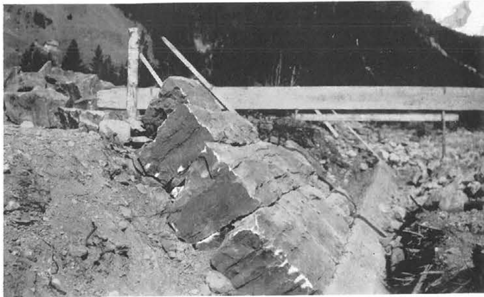
Abb. 114, Seite 79 Kunstgerecht ausgeführtes, angesetztes Trockenmauerwerk
